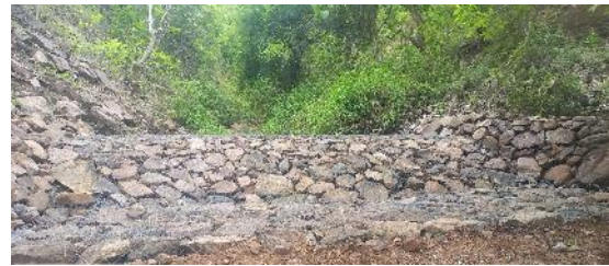
Rock Fill Dam
